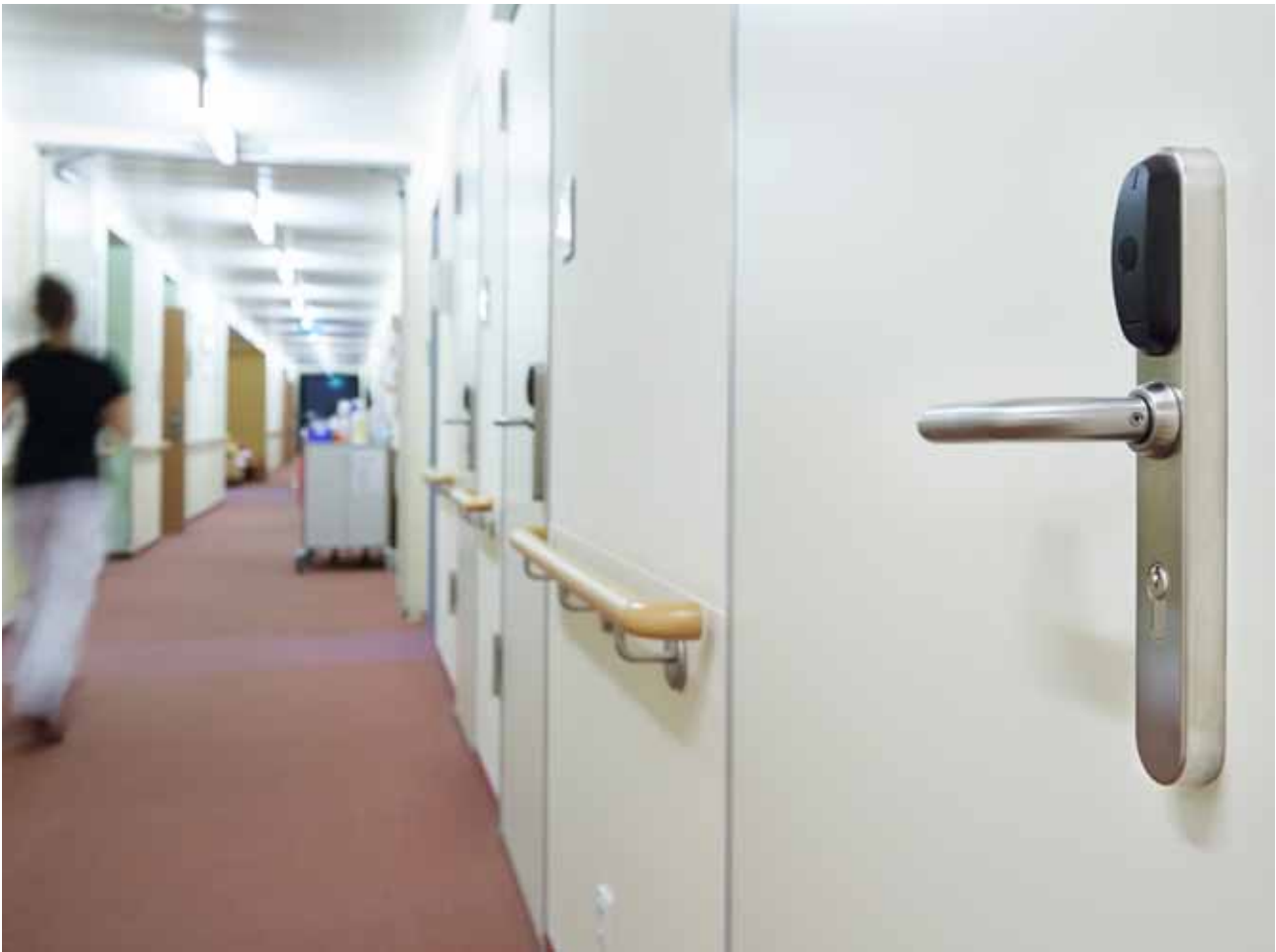
An allen Zimmertüren des Pflegeheims Unterföhring sind XS4 Türbeschläge installiert
