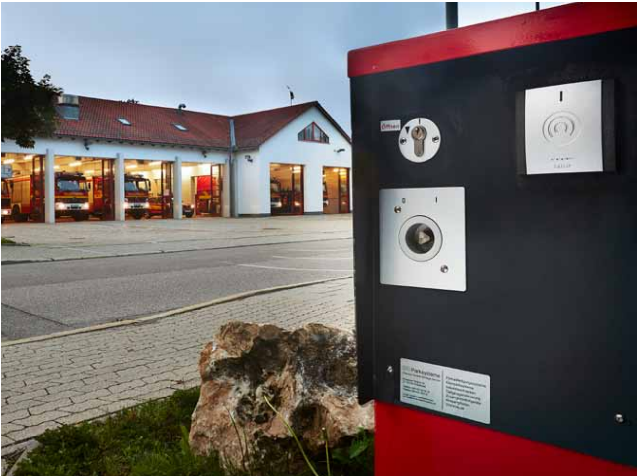
XS4 Wandler zur Steuerung des nicht öffentlichen Parkplatzes der Freiwilligen Feuerwehr Unterföhring
